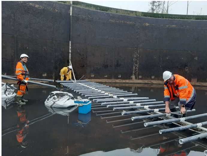
Pose nouvelles membranes
