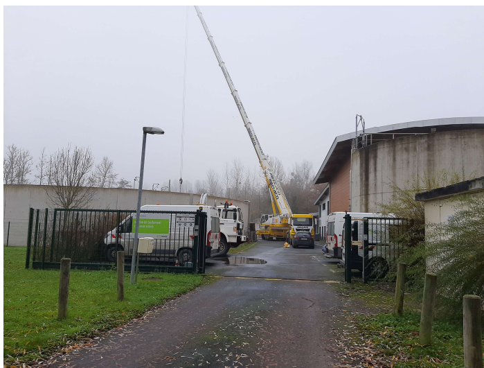
Remplacement des membranes
