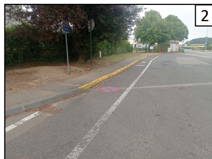
Accès du collège facilité pour les piétons
